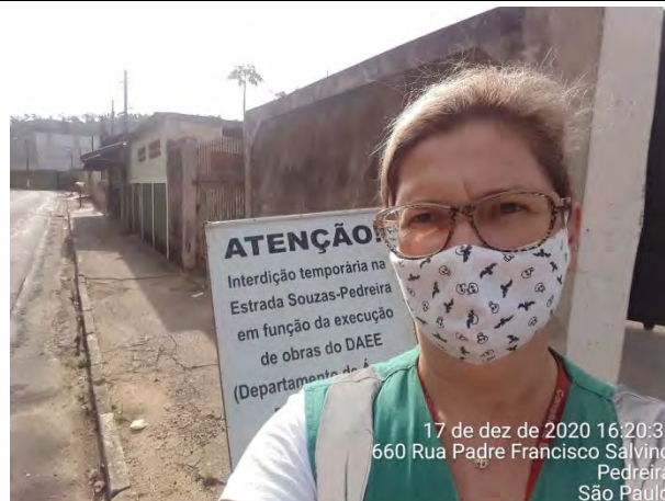
Foto 8 – Apoio no bloqueio de vias para o desmante de rocha – Rua Padre Francisco Salvino. (17/12/2020)
