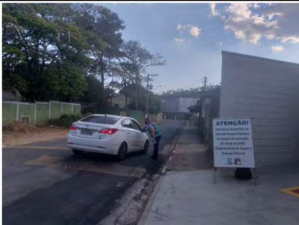
Foto 5 – Apoio no bloqueio de vias para o desmorte de rocha – Rua Padre Francisco Salvino. (02/09/2020)
