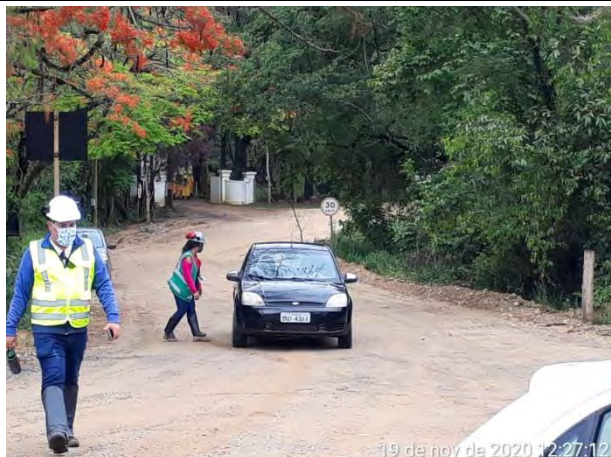
Foto 7 – Apoio no bloqueio de vias na ADA. (19/11/2020)
