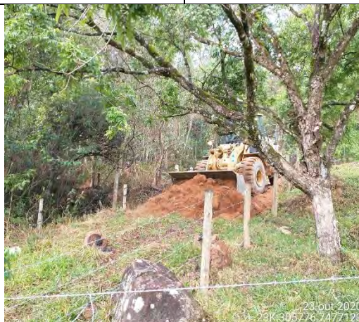
Foto 3 – Início implantação de poço de monitoramento de água subterrânea. Data: (23/10/2020)
