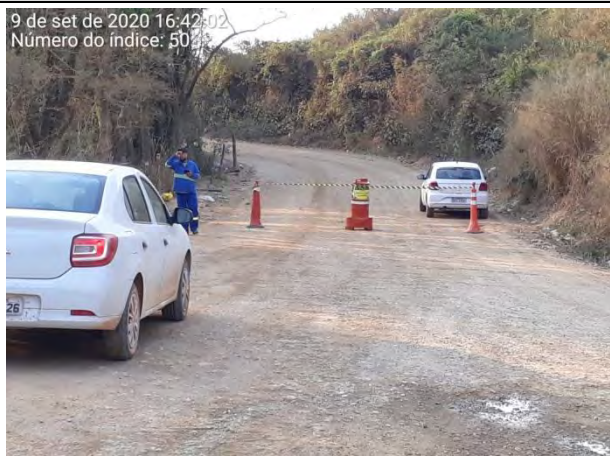
Foto 7 – Apoio no bloqueio de vias para o desmorte de rocha. (09/09/2020)
