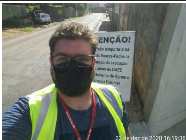
Foto 11 – Apoio no bloqueio de vias para o desmante de rocha – Rua Padre Francisco Salvino. (22/12/2020)
