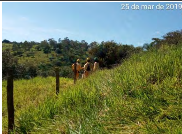
Foto 1 – Finalização do cercamento no Laudo 22 (25/03/2019).
